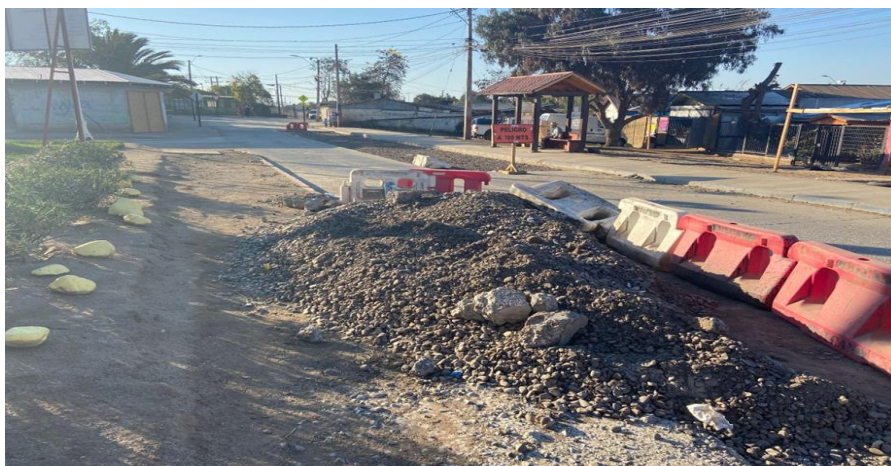
Fotografía 8. Construcción Intervenciones Definitivas de Emergencia sector Poniente.
