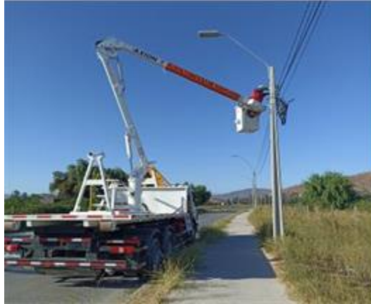
Fotografía 31. Reparación de conectores de luminarias a línea de energía en 07 postes.
