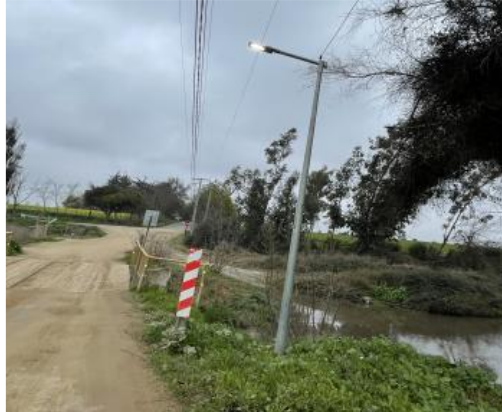
Fotografía 27. Puente Villa Alegre.
