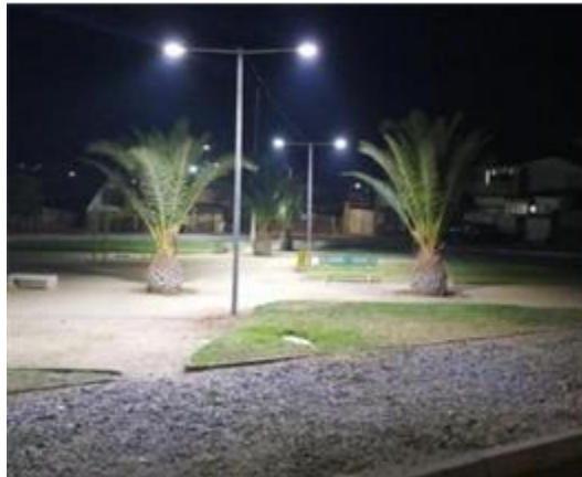
Fotografía 26. Instalación de 05 postes de gancho doble con 10 luminarias led, en centro y costados de plaza Francisco Werchez
