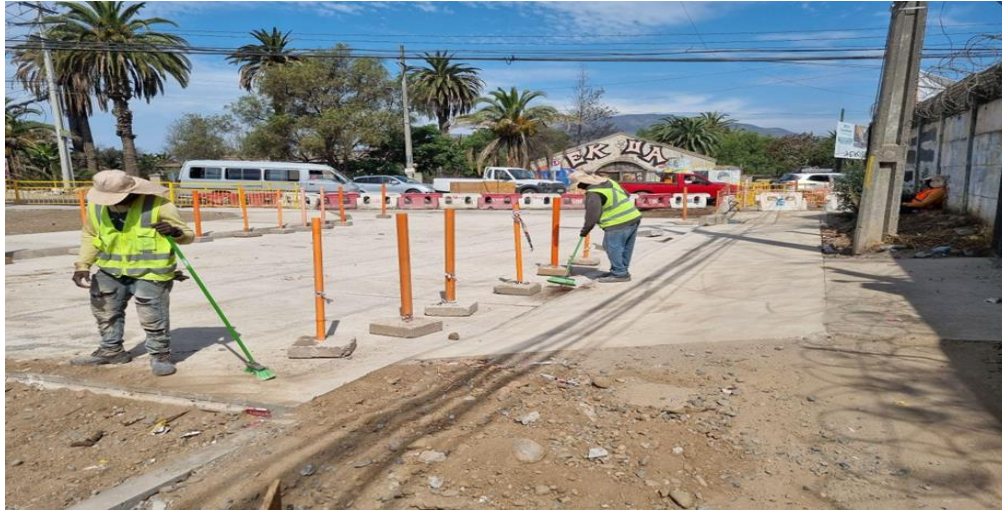
Fotografía 3. Mejoramiento Cruce El Pimiento
