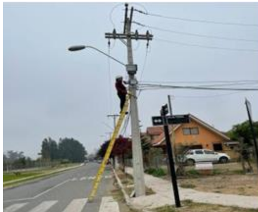
Fotografía 32. Reparación de circuito de Alumbrado Público y cambio de proyector en remplazo de luminaria.
