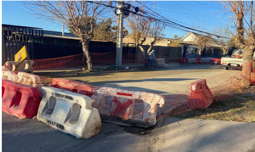
Fotografía 5. Construcción Intervenciones Definitivas de Emergencia Diversos Sectores
