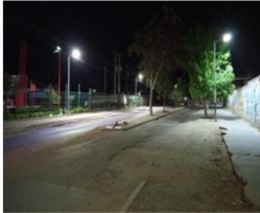
Fotografía 23. Instalación de 05 postes con luminarias led, en calle Alcalde ingreso a Avenida Padre Demetrio Bravo.
