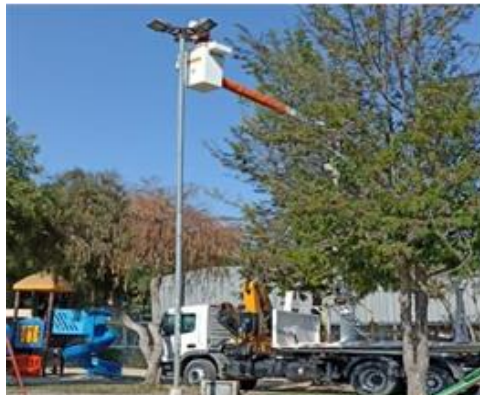
Fotografía 22. Instalación de 03 nuevos proyectores, en plaza Las Talaveras.
