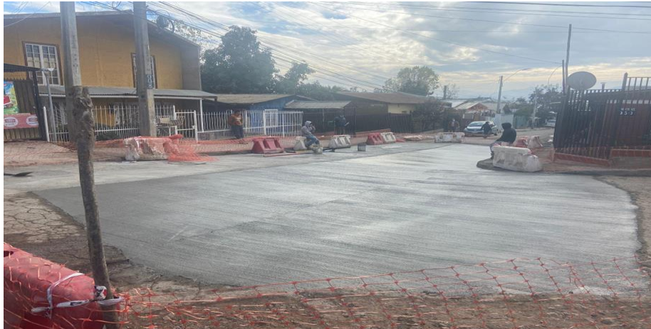
Fotografía 9. Construcción Intervenciones Definitivas de Emergencia sector Poniente
