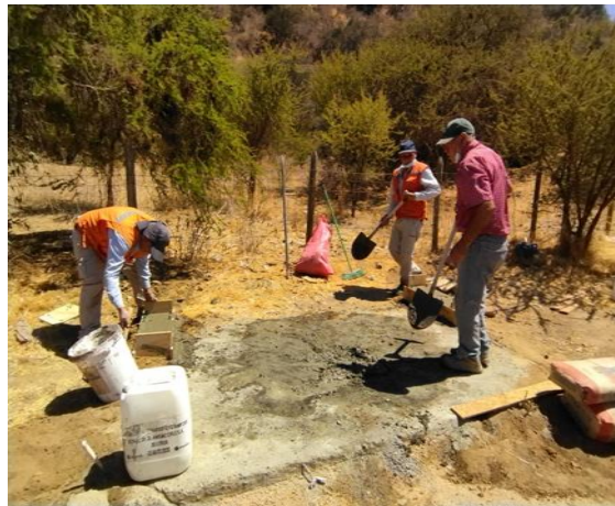
Fotografía 15. Instalación Refugio Peatonal, Tantehue.
