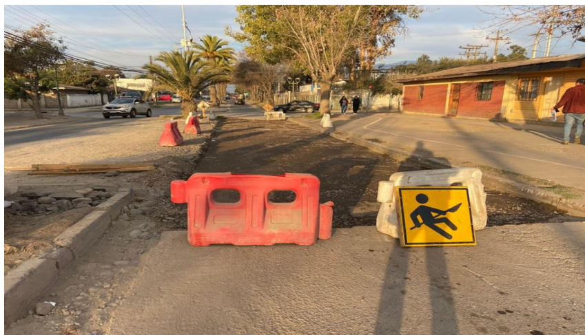
Fotografía 4. Construcción Intervenciones Definitivas de Emergencia Diversos Sectores
