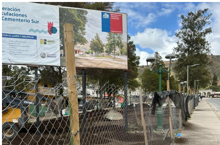
Ejecución de Plaza Cementerio Sur
